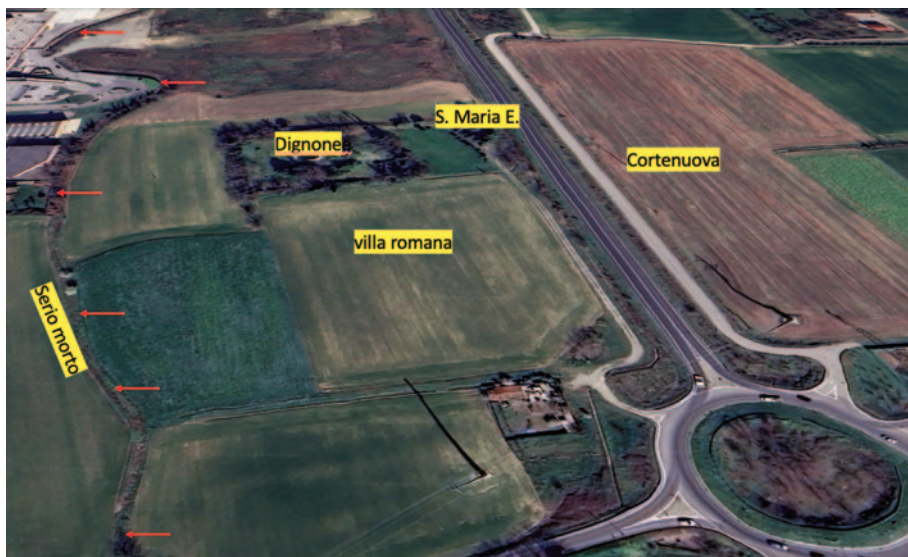
Fig. 1. Il complesso del Dignone sulla riva sinistra del fiume Serio morto (Google earth 18.06.2024).
